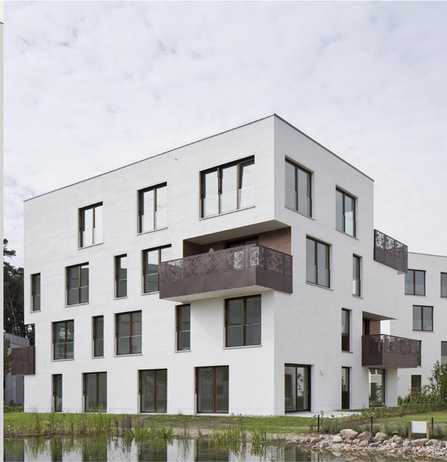
Alternativ: Perforiertes Lochblech Geländer in Verbindung mit Glasabsturzicherung
